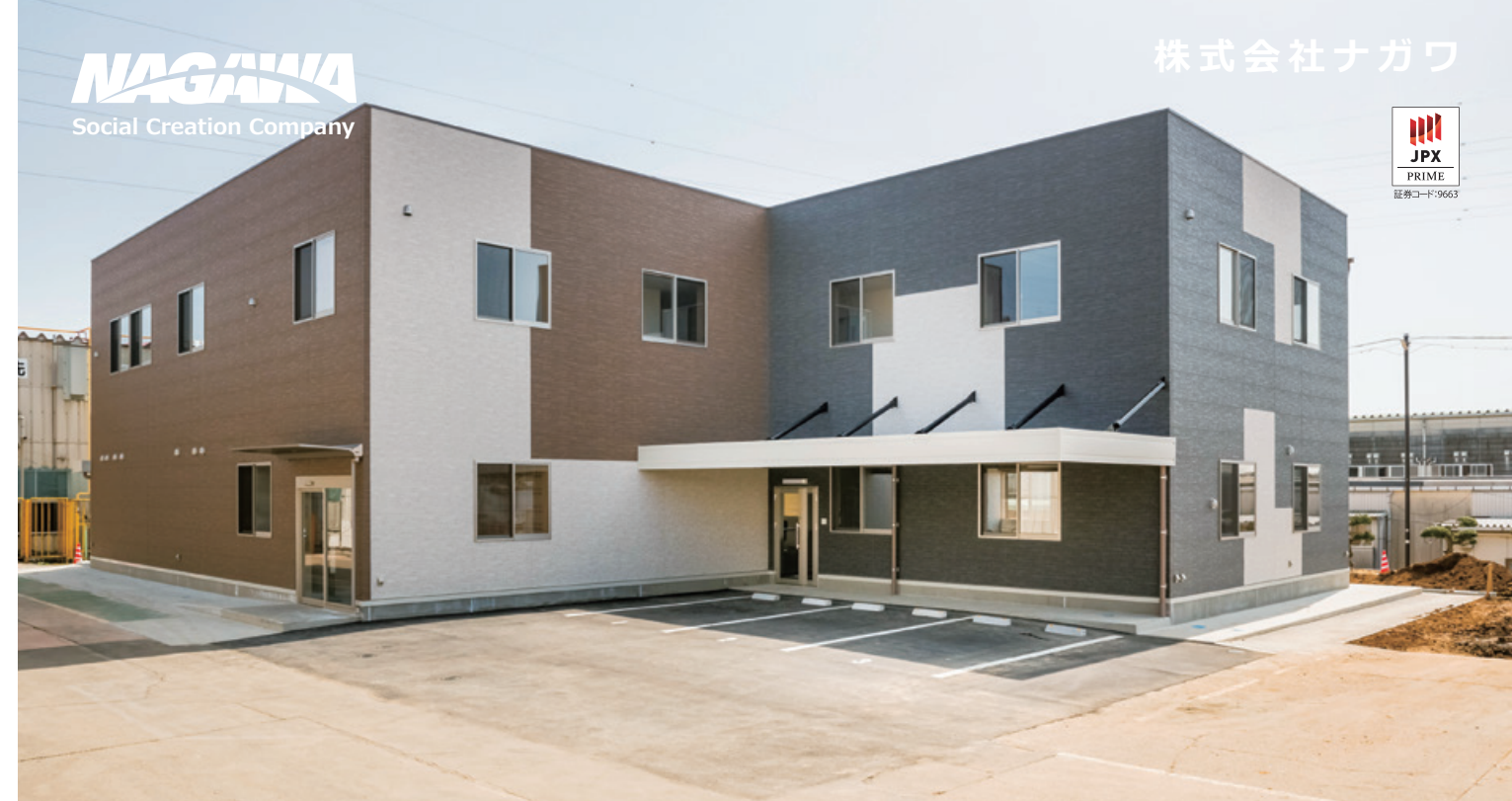
建材製造業事務所
