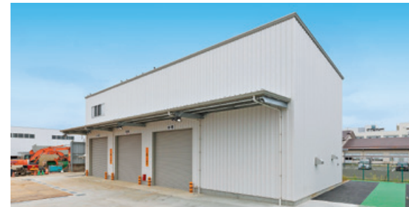
機械整備工場
