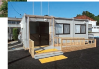
応急仮設住宅 (山口県)
