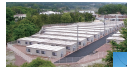
応急仮設住宅 (宮城県)
